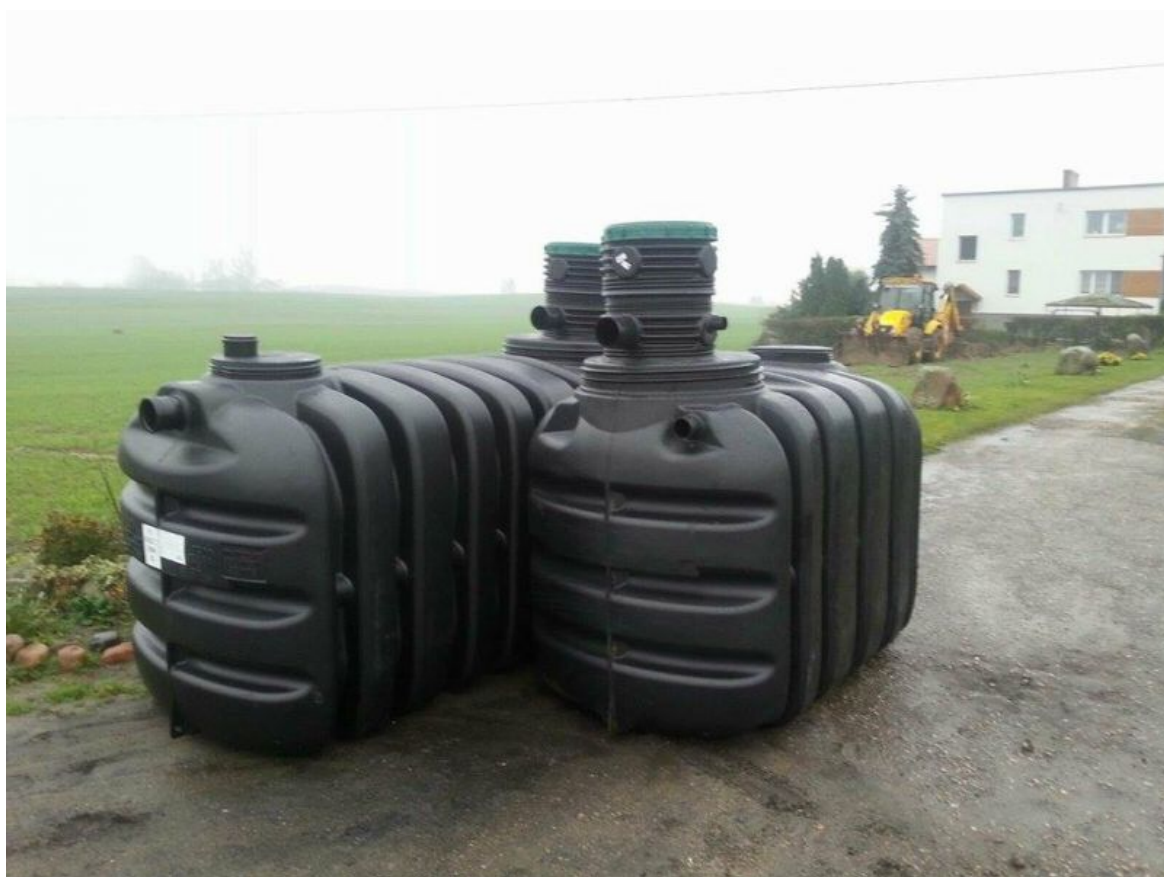
Fot. 4 Budowa dwudziestu pięciu przydomowych oczyszczalni ścieków
