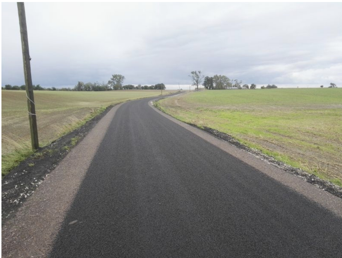
Fot. 5 Przebudowy drogi gminnej Bielawy – Ostrowo
